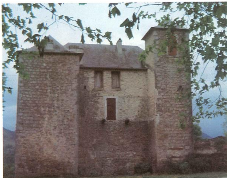
Harrieta bere sohailuaren harriekin
